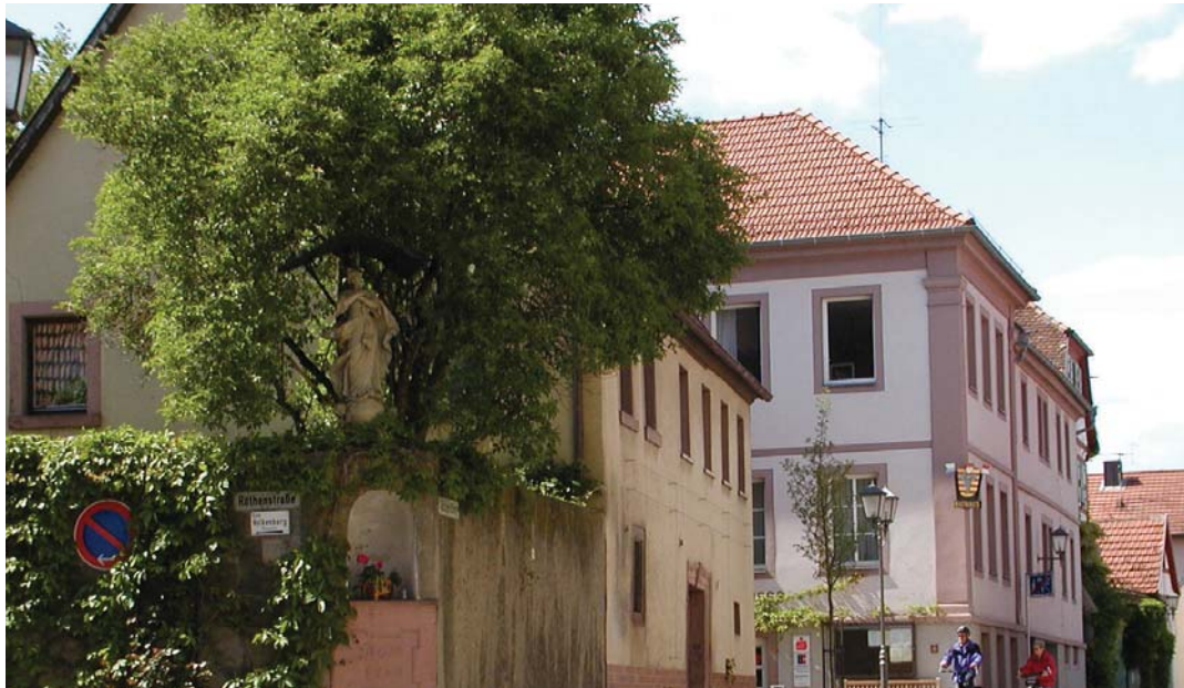
Das Rathaus wurde im Zuge der Dorferneuerung im Jahre 1993 ebenfalls hergerichtet.
