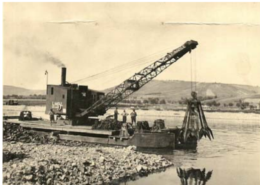
Mit Hilfe von Kran und Loren wurden kurz nach dem Krieg die Altwässer mit Kriegsschutt aus dem zerbombten Würzburg aufgefüllt. Erst dann konnte der Rasenplatz erstellt werden.
