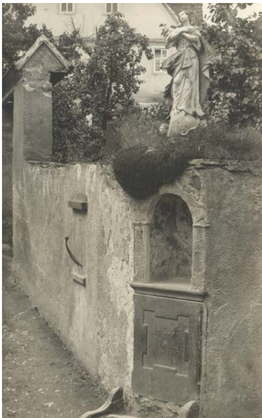
Eine längst vergessene Wasserentnahmestelle am Weckesser Haus. Wasser musste nahezu täglich mühsam in's Haus geschafft werden!
