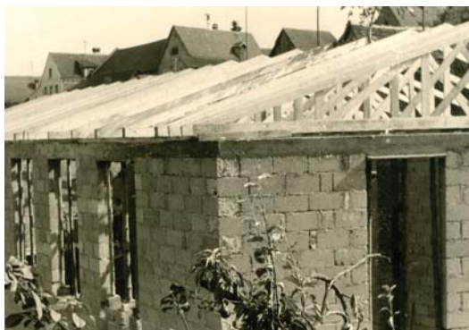
Der Rohbau mit Dachstuhl der Turnhalle konnte zum 80-jährigen Jubiläum des TSV rechtzeitig fertiggestellt werden.
