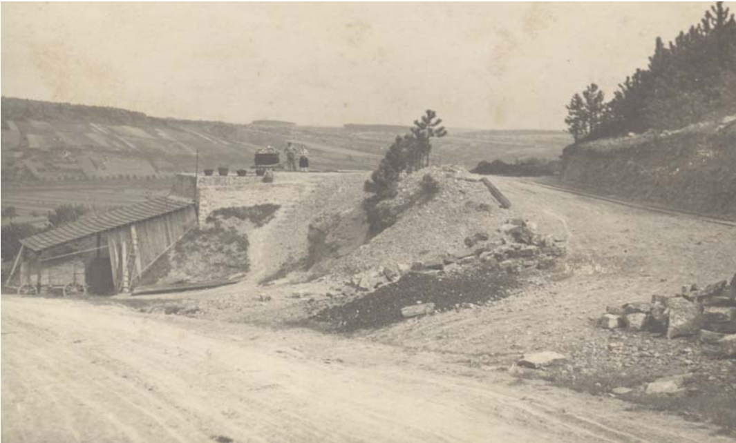
Der Kalkofen wurde 1925 erbaut.
