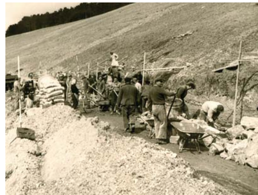
Bau der Weinbergsmauern im Hüttental, erstellt in Eigenleistung aller beteiligten Weinbergbesitzer!
