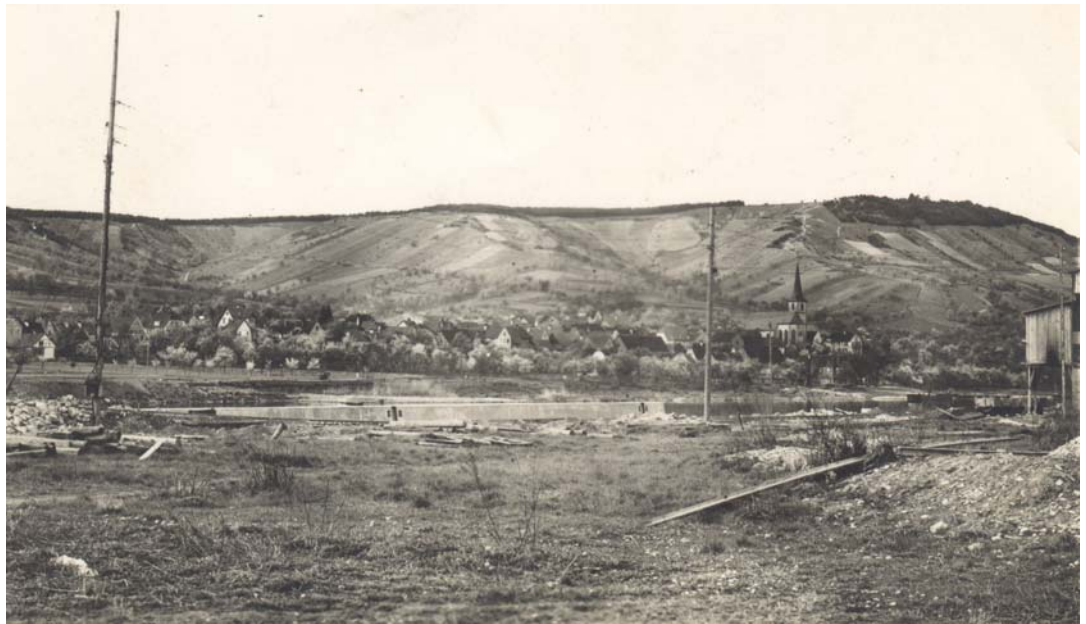
Ein Baustellenbild der Schleuse auf der anderen Mainseite aus den Jahren 1933/34. Es fällt auf, wie viele Äcker und Weinberge und wie wenig Schwarzkiefern wir damals hatten.
